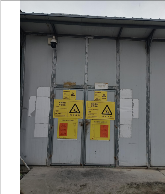
危废暂存间外部
